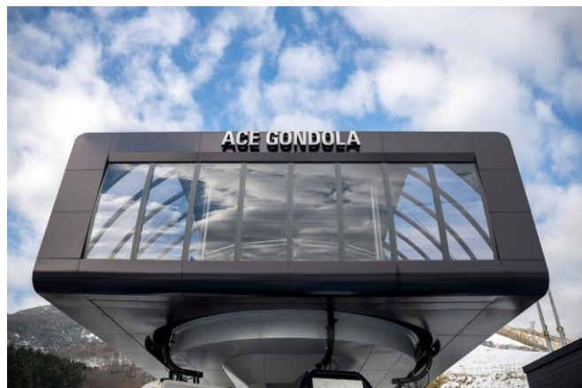
エースゴンドラ山麓駅舎
